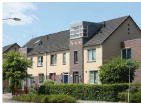
Dakopbouw afgestemd op de architectuur van het hoofdgebouw en 'licht' bouw materiaal.
