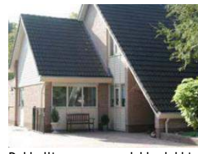
Dakhelling en dakbedekking overeenkomstig hoofdgebouw.
