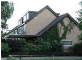
Overkapping aan de zijgevel die plat afgedekt is.
