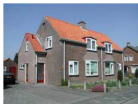
Verbeteringen aan gevel met hetzelfde kleur- en materiaalgebruik.
