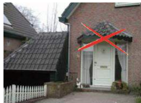
Overkapping met een dakhelling die niet overeenkomstig het hoofdgebouw is.
