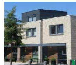
Goed teruggeplaatst en passende kozijnindeling.
