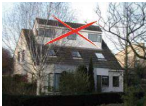
Dakopbouw op een schuin dakvlak die boven de daknok van het hoofdgebouw komt.
