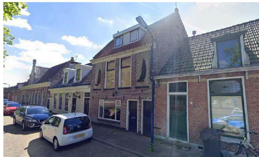
De woningen aan de Tuinen (noord) variëren in hoogte tussen de één en twee lagen, waarbij de gothoogtes, nokhoogtes en kapvormen van elkaar verschillen. Ook hier staat de gevel direct aan de straat.
