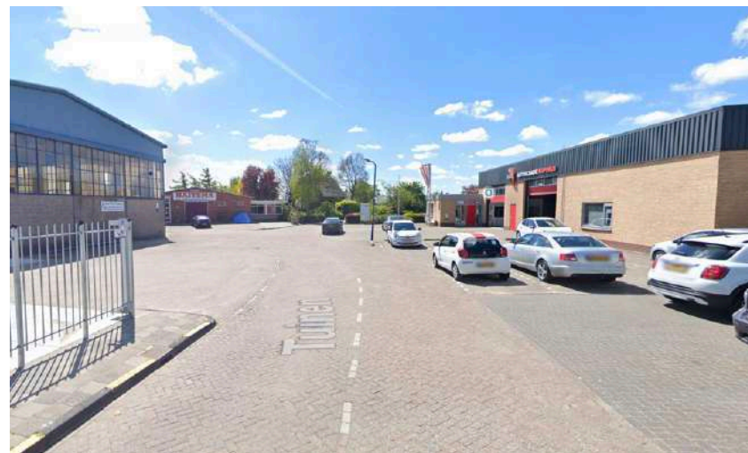
Het bedrijventerrein inclusief de werf bestaat uit een functionele inrichting met grote volumes die divers in vorm zijn (loodsen met kap, zonder kap, enzovoorts) en ten opzichte van elkaar divers georiënteerd zijn.
