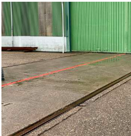
De bestaande stelconplaten worden hergebruikt
