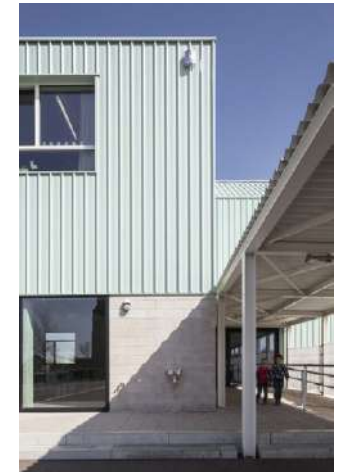
Trasraam ca. 2 meter metselwerk
