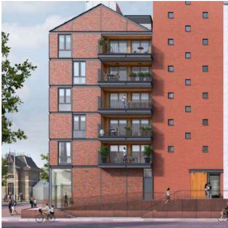
Uitkragende balkons boven elkaar, als externe constructie vormgegeven
