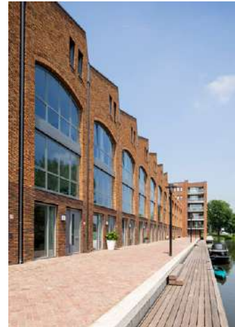
Dakvorm en gevelopbouw met grote boogramen
