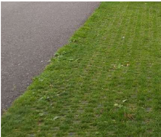
De parkeerplaatsen zelf zijn vormgegeven in grasbetontegels
