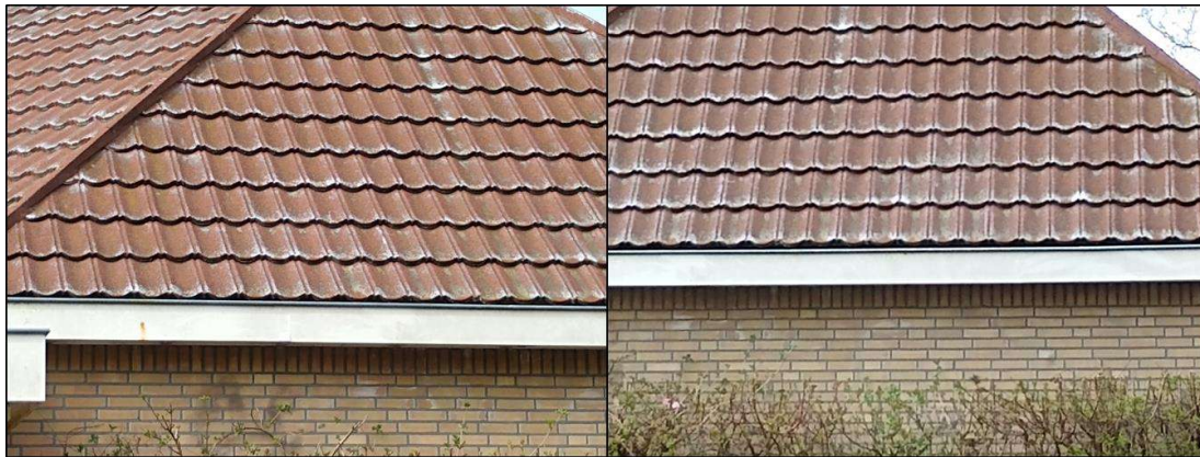
Figuur 2.1.: De dakpannen van het dak van het schoolgebouw in het plangebied sluiten strak op elkaar aan.
