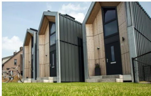
▲ Verschillende flexwoningen: v.l.n.r. de Heijmans One, Nezzt en Finch.
