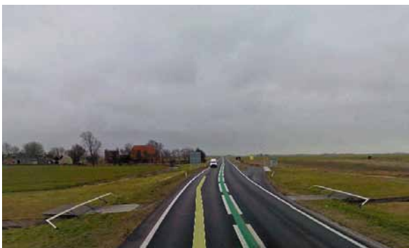
Fietstunnel onder N31
