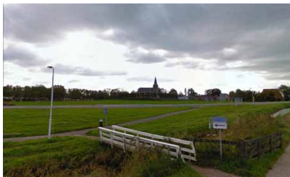
Voet-fietsbrug in verlenging van Tiltsjedyk
