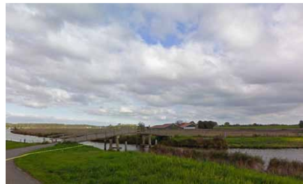
Fietsbrug Turkweg aan de overkant van de vaart
