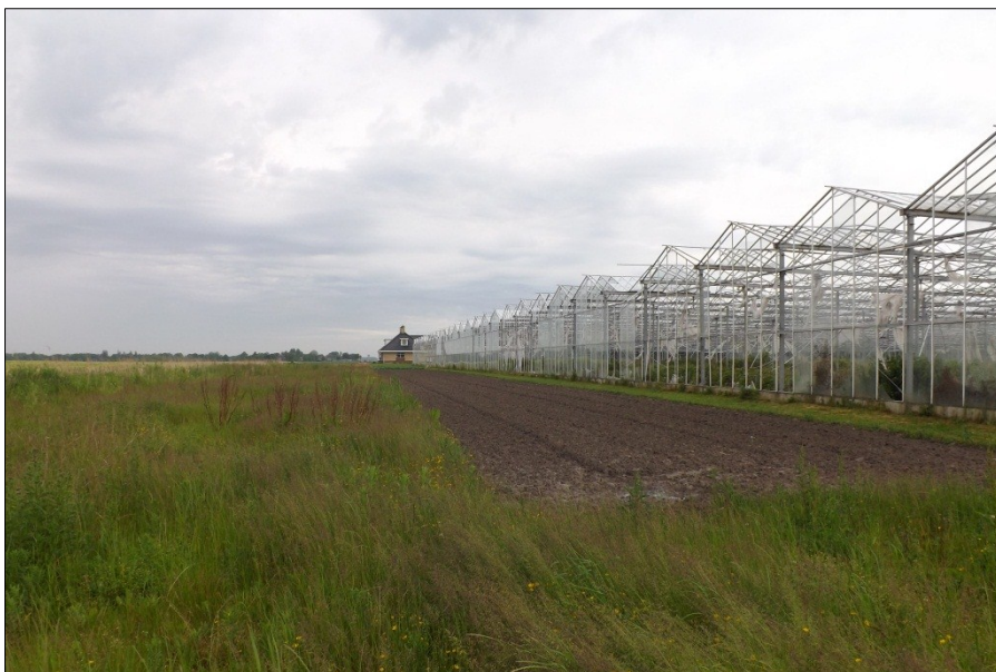
Figuur 7. Westzijde plangebied vanuit het zuiden
