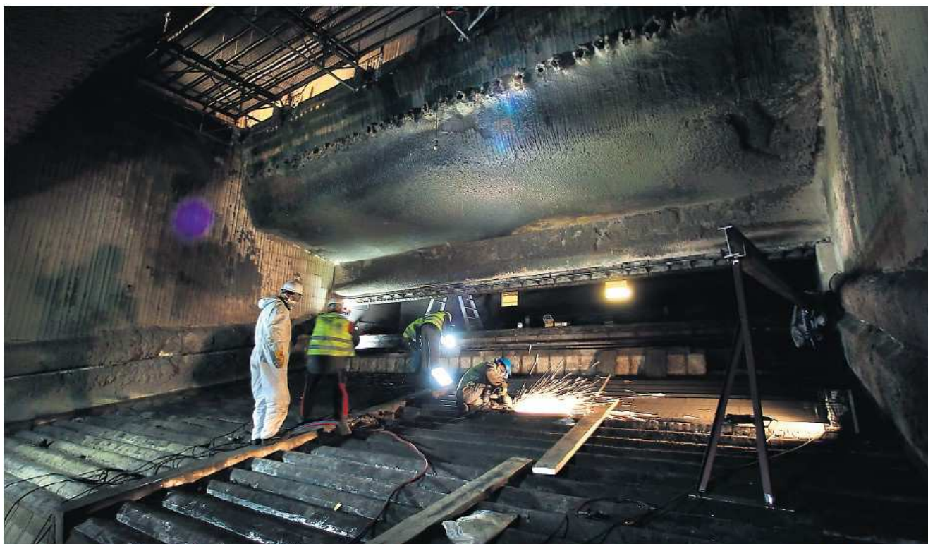
Een medewerker freest bobbeljes gesmolten metaal van de bewegende vloer van de reststoffenenergiecentrale in Harlingen. Hierop wordt het afval geschoven vanuit de brede koker erachter. Normaal is hier de temperatuur zo'n 1100 graden Celsius. FOTO CATRINUS VAN DER VEEN
