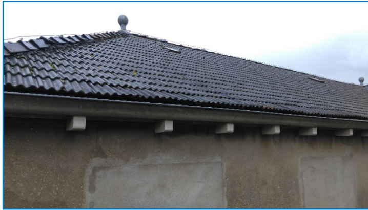
Detail van dak met pironnen, pannen en bakgoot
